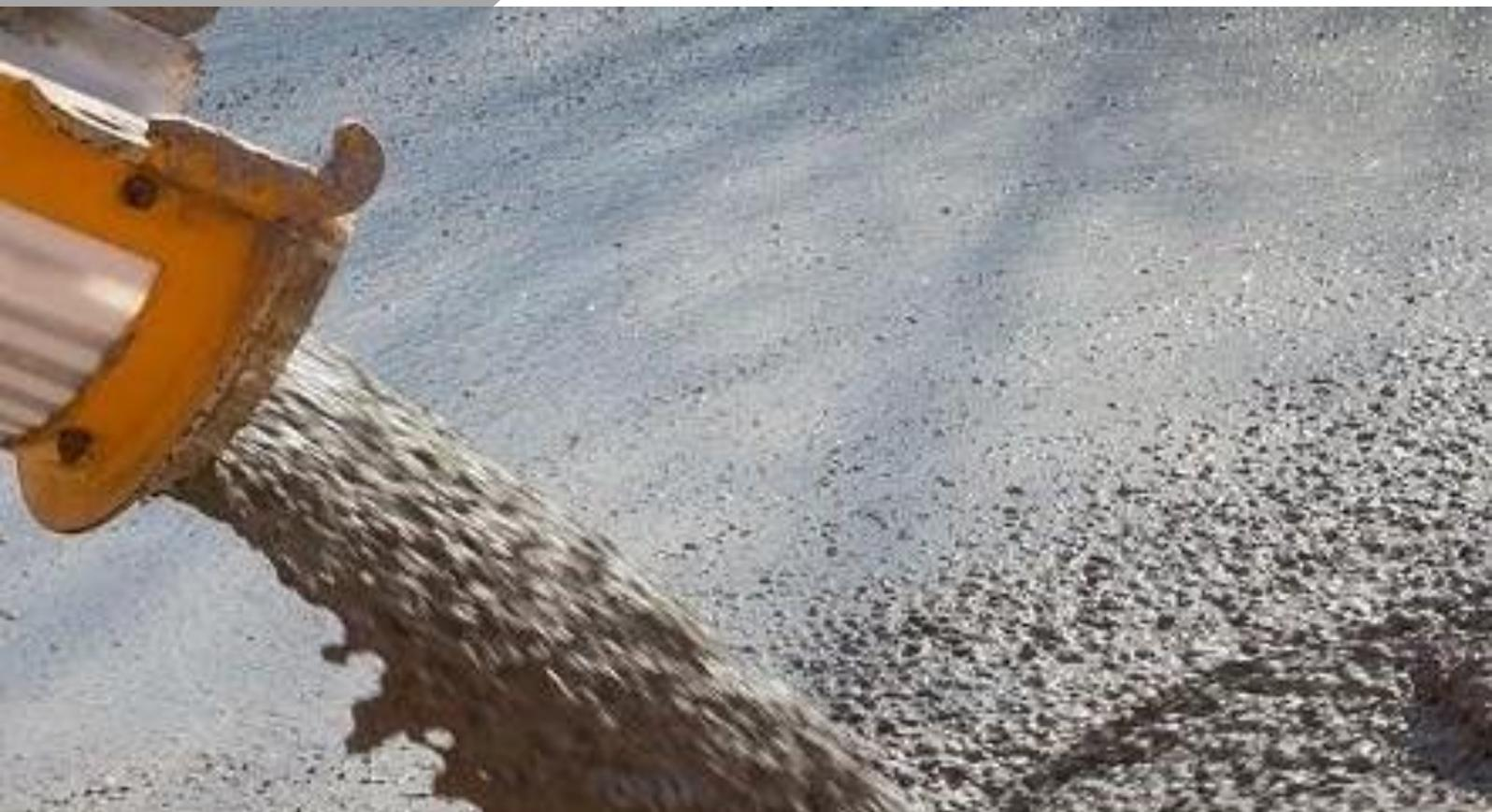
Es un concreto altamente fluido, sin segregación, llenando la formaleta y encapsulando el refuerzo con una mínima consolidación mecánica. La viscosidad es una de sus características más importantes en estado plástico.
